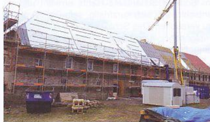
Die Baustelle „Torbogenhaus“ vorm Schloss Schönefeld
